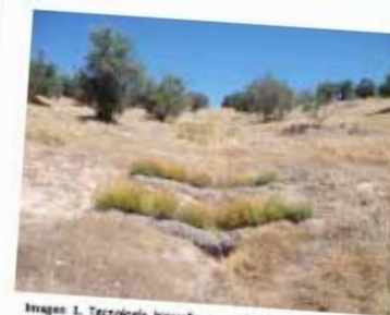
Imagen 1. Tecnología biorrollo + gavión de piedra + plantas nitrófilas bien implantadas.
