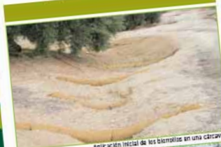
Aplicación inicial de los biorrollos en una cárcava.
